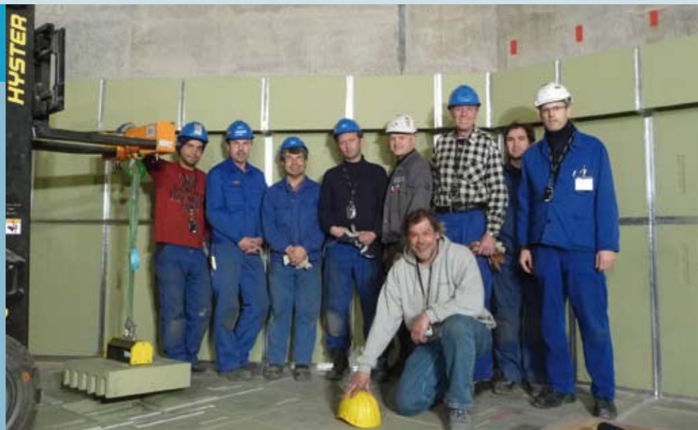
Einsatz des letzten Kühlblocks von 849 Elementen – ein „Meilenstein“
