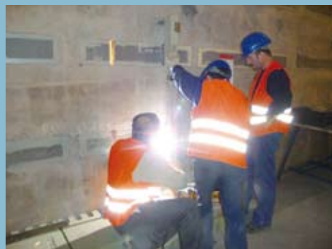
Anschweißen von Halteprofilen für die Wandelemente
